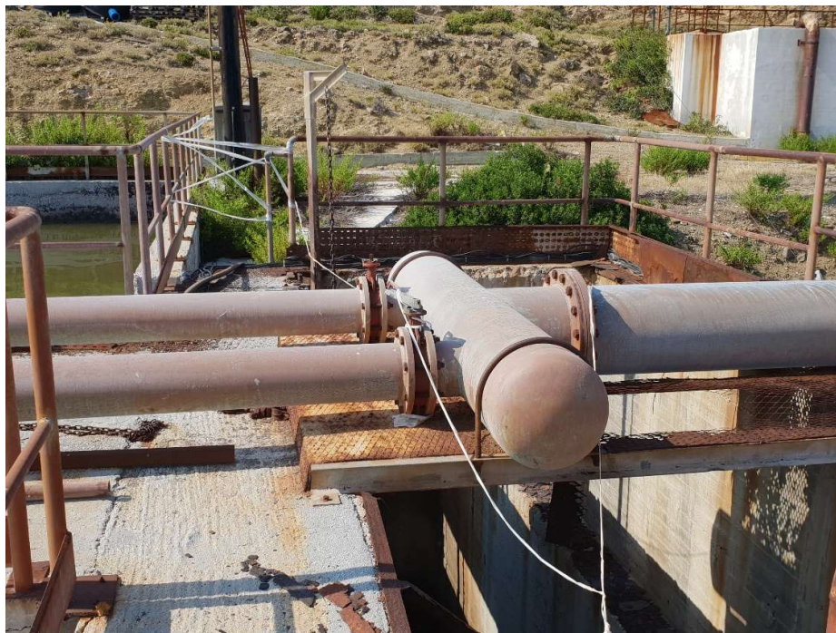
Εικόνα 6. Δεξαμενή Απαέρωσης
