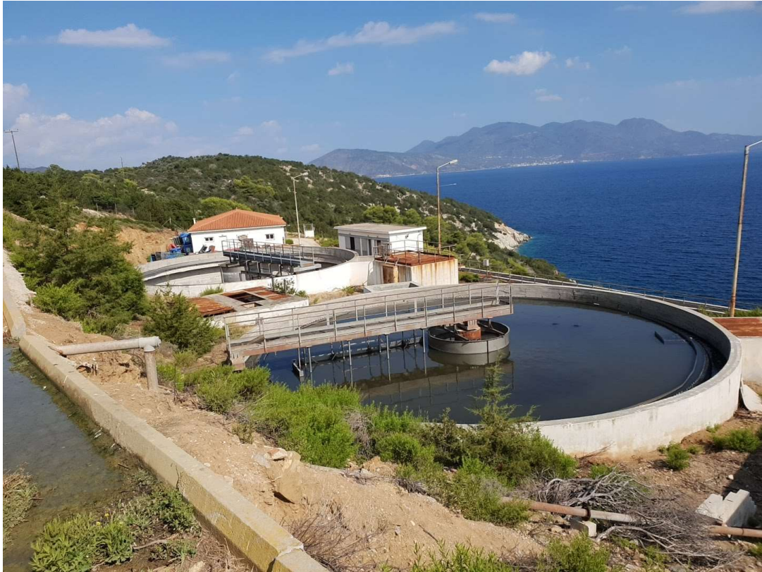
Εικόνα 7. Δεξαμενή καθίζησης
