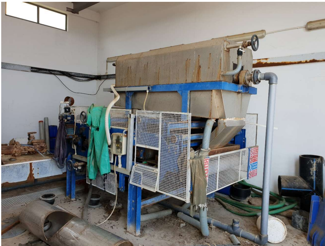
Εικόνα 13. Μονάδα Αφυδάτωσης – Ταινιοφιλτρόπρεσσα
