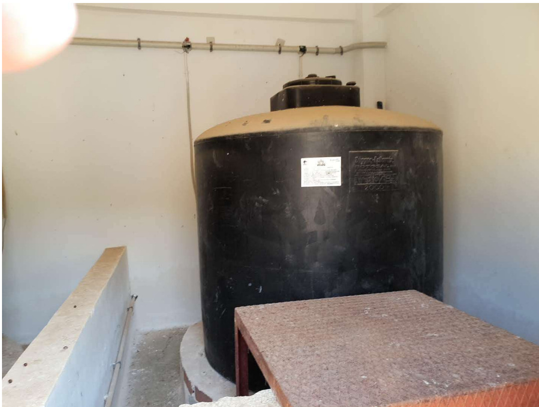
Εικόνα 9. Δεξαμενή αποθήκευσης διαλύματος NaOCl
