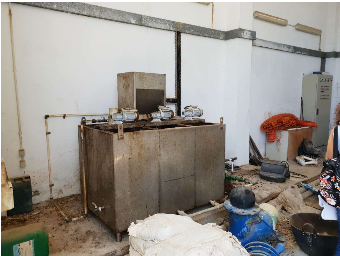
Εικόνα 12. Μονάδα Αφυδάτωσης – Πολυηλεκτρολύτης
