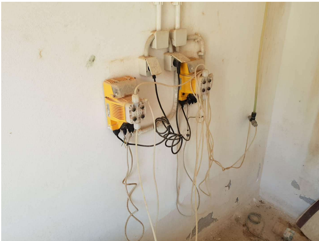
Εικόνα 10. Δοσομετρικές αντλίες NaOCl
